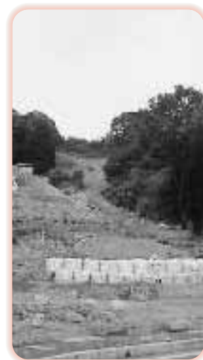
↑ 台風21号でも大変な被害、沼地区で土砂崩れ。道路反対側の家まで壊してしまいました。
